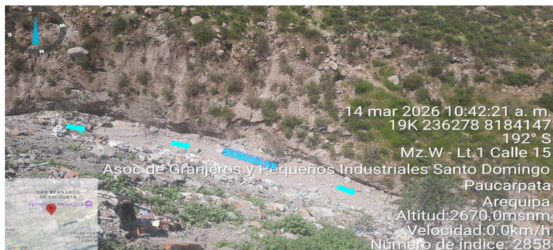
Imagen N° 3. Zona colmatada en el tramo, en donde se observa sedimentación en el cauce de la quebrada S/N.
